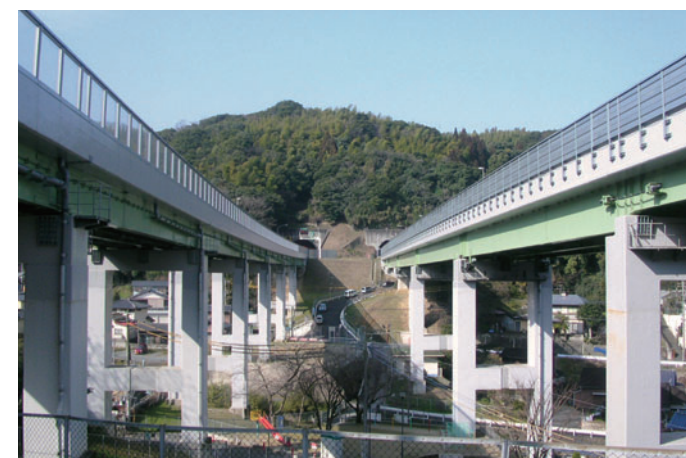
塗替え塗装完了後の金山橋。
