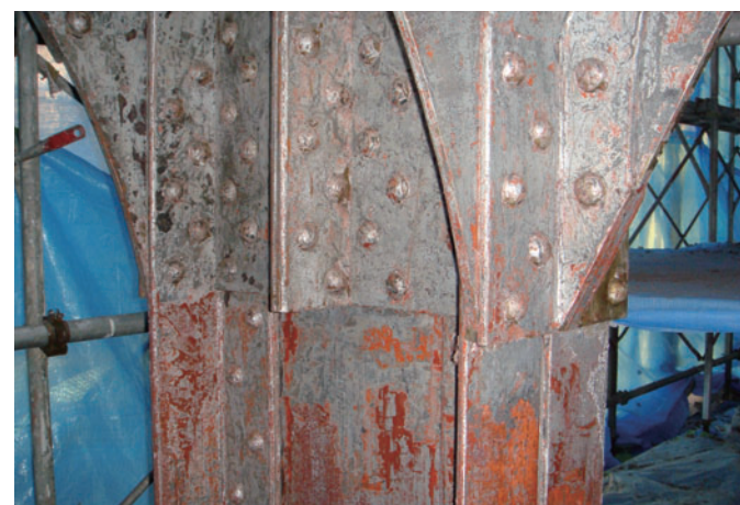
2回目の塗膜の除去作業完了。
