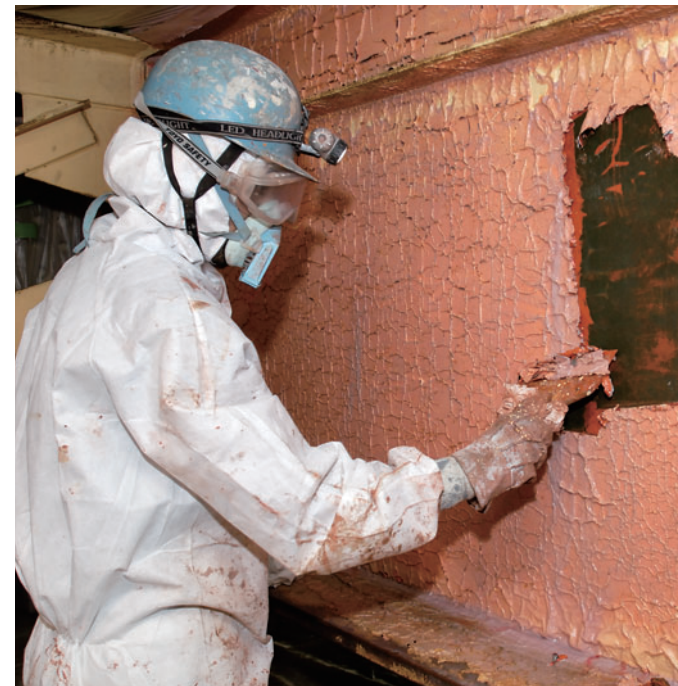
スクレーパーで容易に旧塗膜が除去できるため、電動工具処理に比べて騒音は低く抑えられました。
