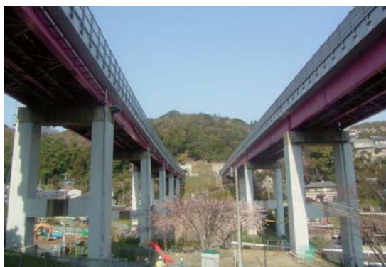
北九州高速4号線 金山橋
