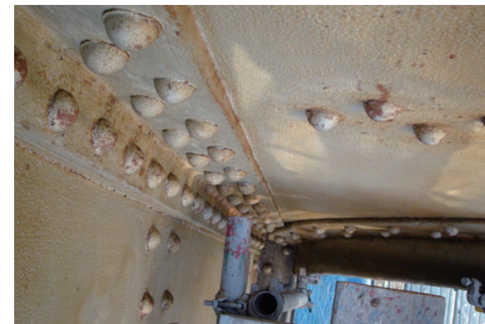
1回目のインバイロワン塗付。厚い塗膜が軟化しました。
